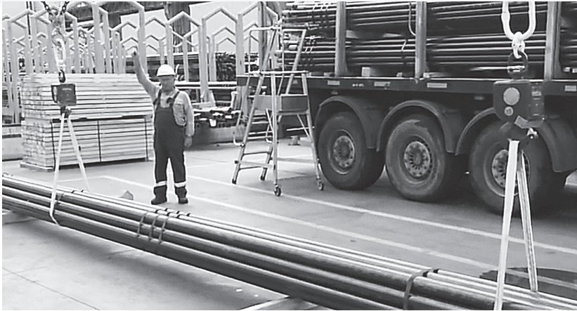
パイプの運搬に採用した例
